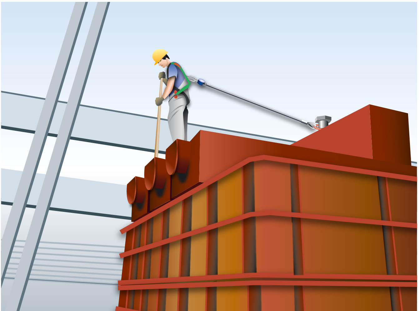
Abb. 18 Absturzsicherung auf Formkästen
