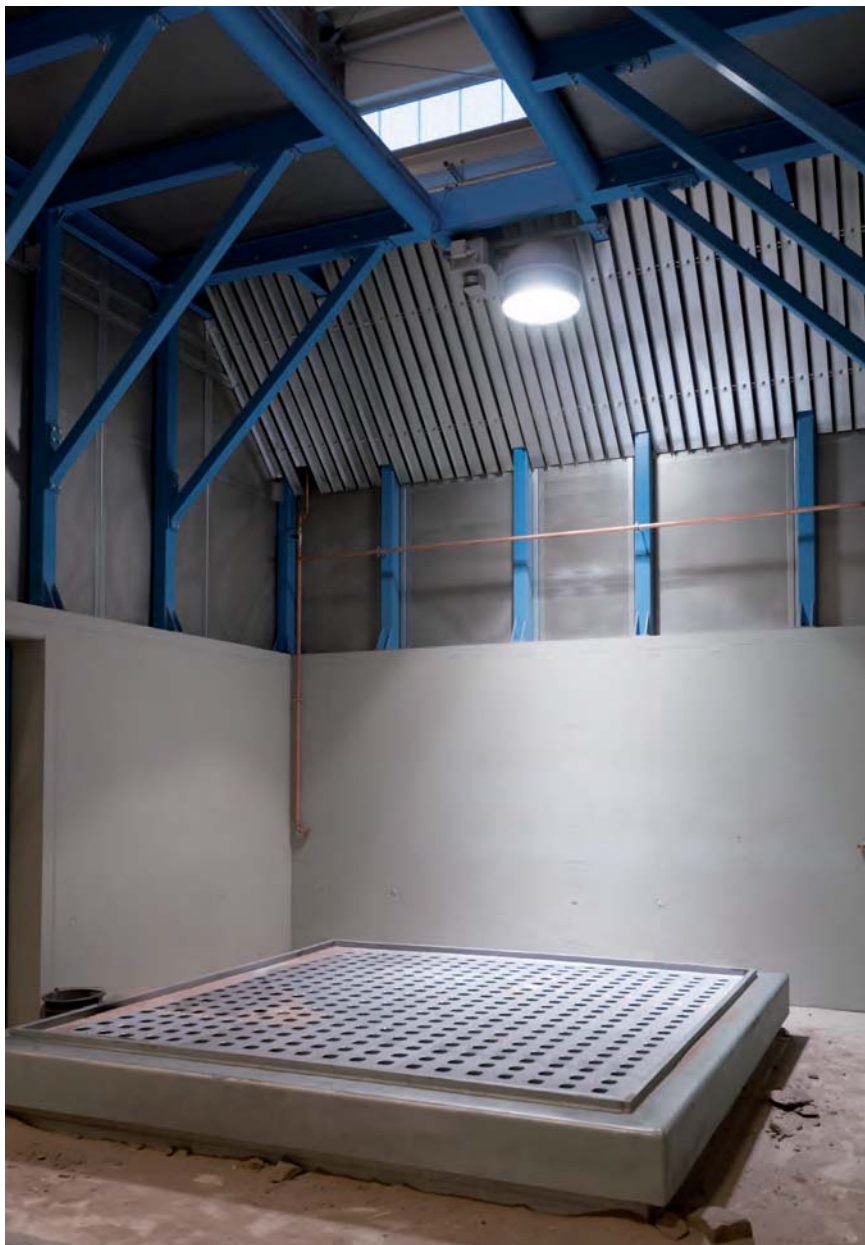
Bild 4: Der bei der mechanischen Regenerierung freigesetzte Staub wird über eine großflächige Deckenabsaugung entfernt.
