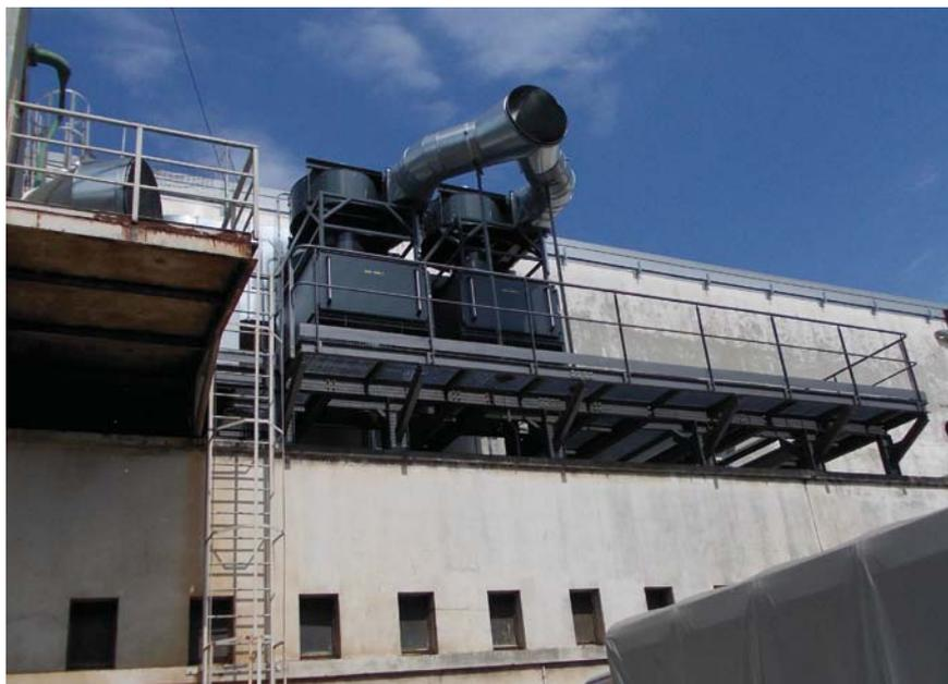
**Bild 1: Zentralisierte Filterstation, angebracht im Außenbereich der Produktionshalle.**
