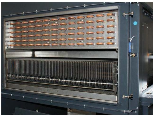
**Bild 2: Offene KMA-Abluftfilteranlage mit Demister, Elektrofilterzelle und Wärmetauscher (von unten nach oben).**
