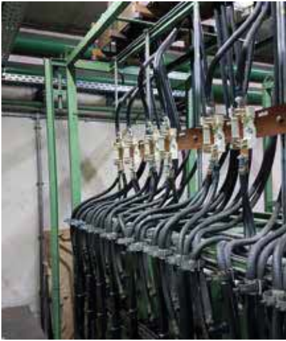
Bild 3: Kondensatorbatterie nach dem Umbau.
