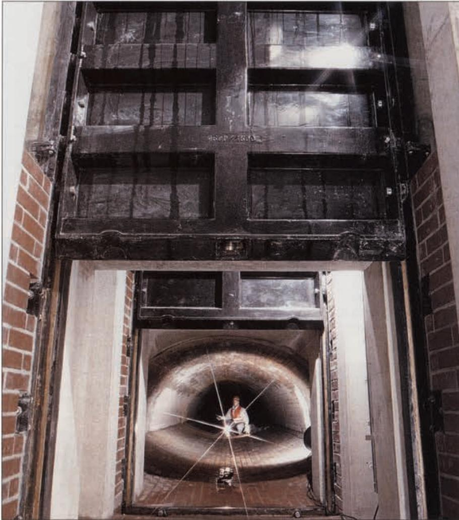
Absperrschieber aus GJL-250 für einen Abwasserkanal, Abmessungen: 1500 × 1500 mm
