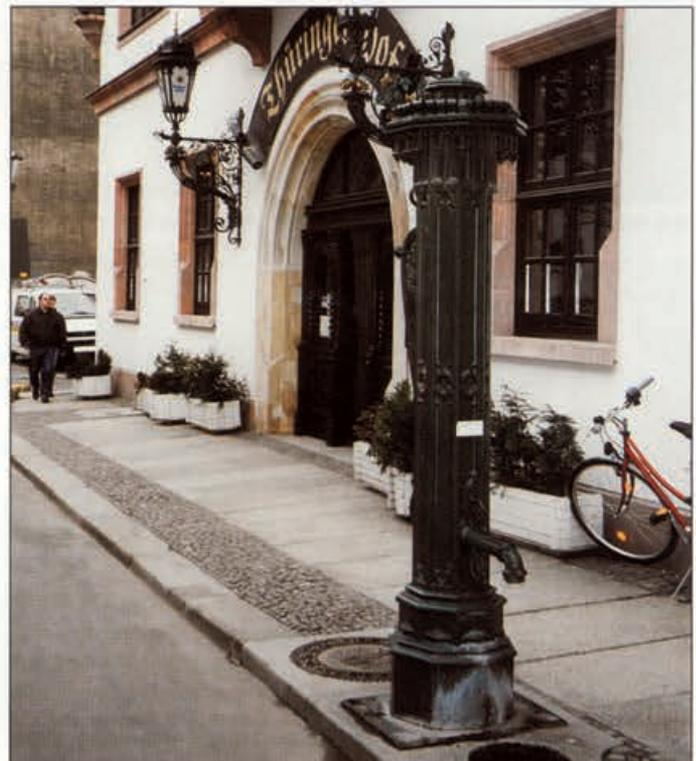
Aus 57 Einzelteilen bestehende gotische Pumpe, Werkstoff: GJL-200
