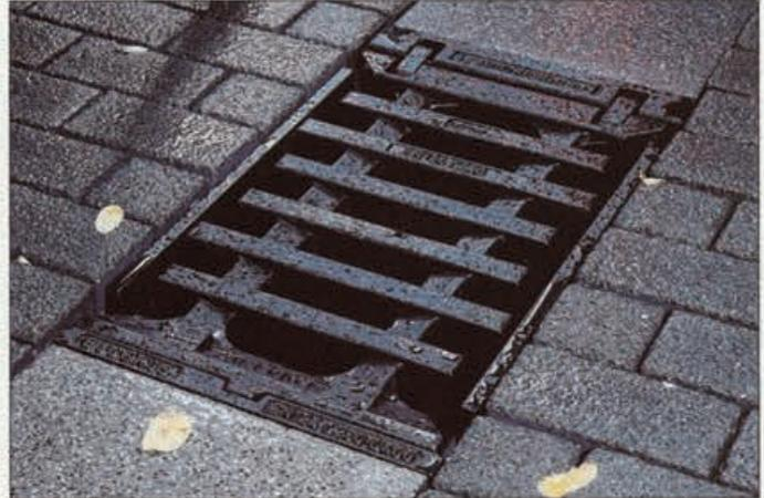
Je nach Einbaustelle werden Straßenabläufe aus GJL-250 oder -300 in den unterschiedlichsten Konstruktionen mit Belastungen von 15 bis 900 kN hergestellt
